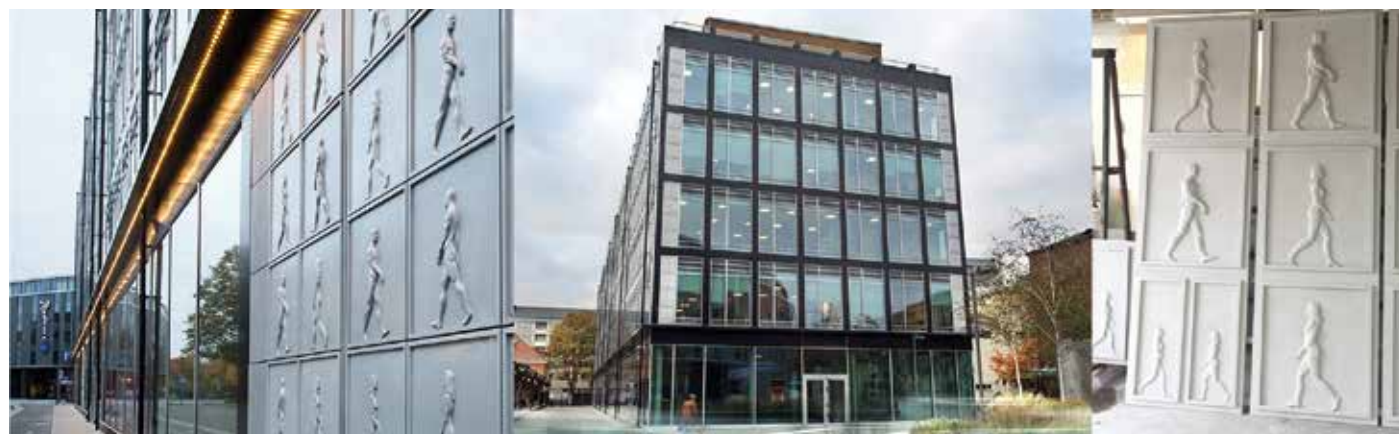
Ett Super Deco-hus i kv Eldaren i Uppsala. Monsén Arkitekter
